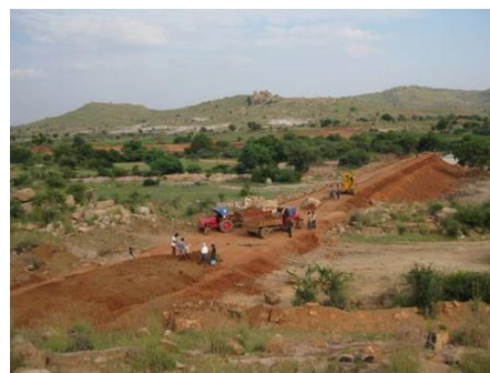
Construcción del talud
