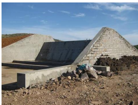
Construcción del dique
